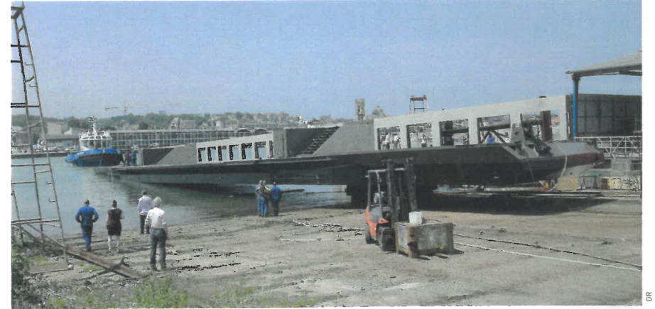
Mise à l'eau à Dieppe.
